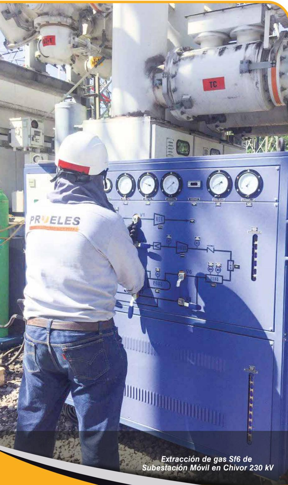
Extracción de gas Sf6 de Subestación Móvil en Chivor 230 kV
